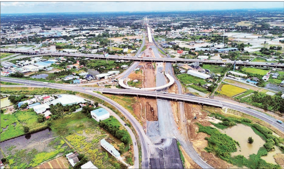
Nút giao kết nối Vành đai 3 - đường cao tốc Bến Lức - Long Thành và Thành phố Hồ Chí Minh - Trung Lương.
