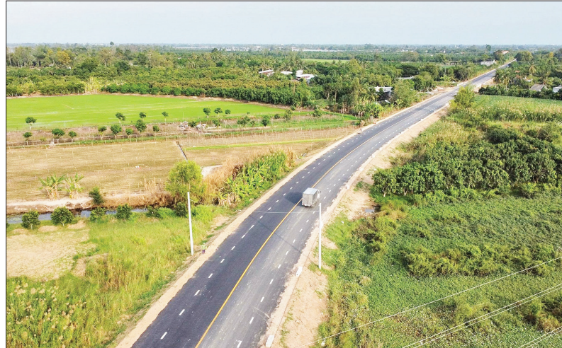
Quốc lộ 30 đoạn Cao Lãnh-Hồng Ngự giai đoạn 3 đã được nâng cấp, đưa vào hoạt động.
