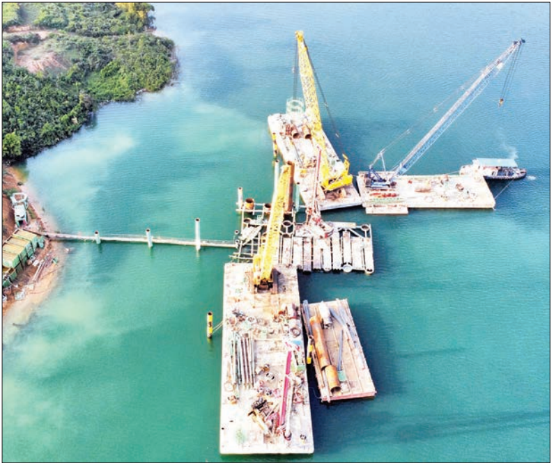
Thi công cọc khoan nhồi trụ tháp cầu Hòa Sơn - cầu dây văng có nhịp chính dài 550m, lớn nhất Việt Nam.
