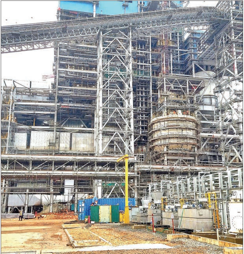
Một hạng mục của nhà máy với hàng nghìn thiết bị, cấu kiện.
